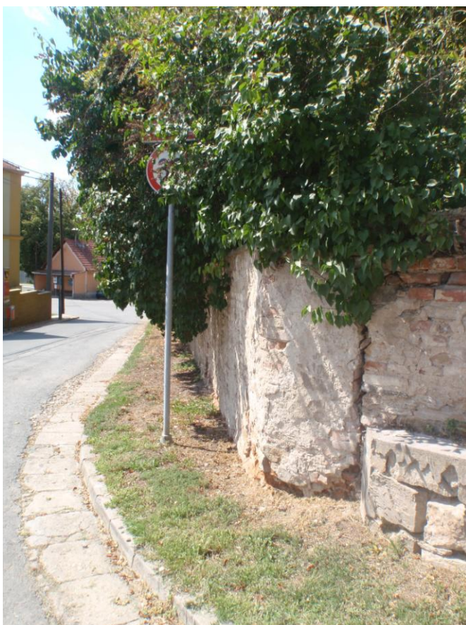
Trhlina na přechodu IV. a V. úseku je čistě dilatační a proto bude opatřena příznanými nerezovými dilatačními lištami.
