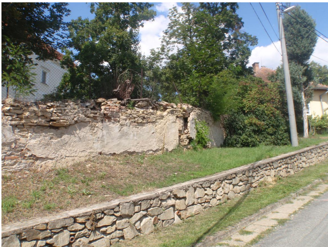
Degradované a narušené části zdi V. úseku budou rozebrány a opětovně vyzděny.
