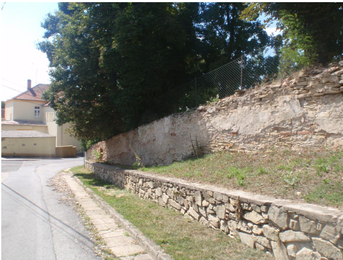
Pohled na V. úsek. Dojde zde k obnovení cihelného zhlaví a realizaci nového oplocení v koruně.
