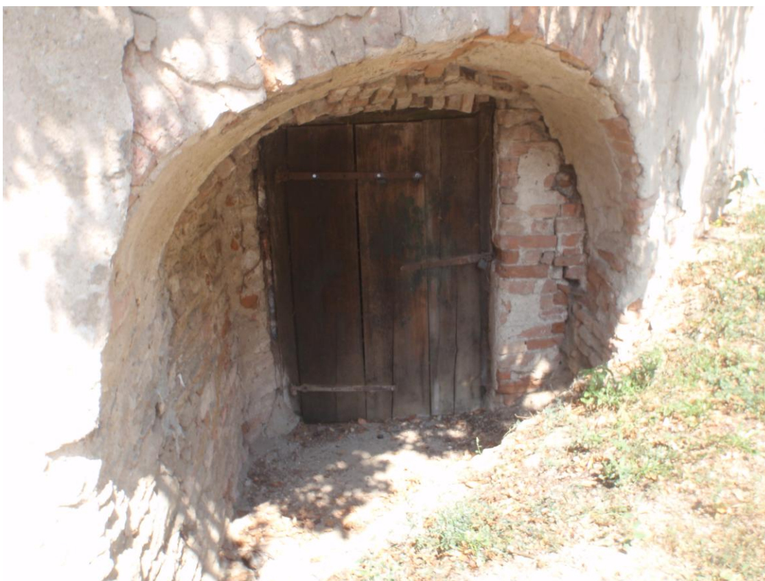
Součástí sanace bude i vstupní průčelí do klenutého sklepa. Narušené klenutí zde bude vyklínováno, plombováno a hloubkově vyspárováno.
