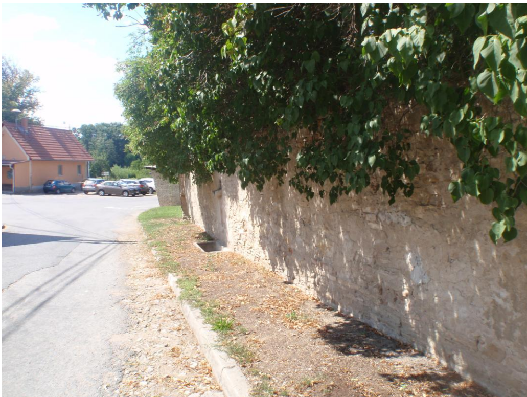
Vybočující část IV. úseku bude sanována zemními kotvami.
