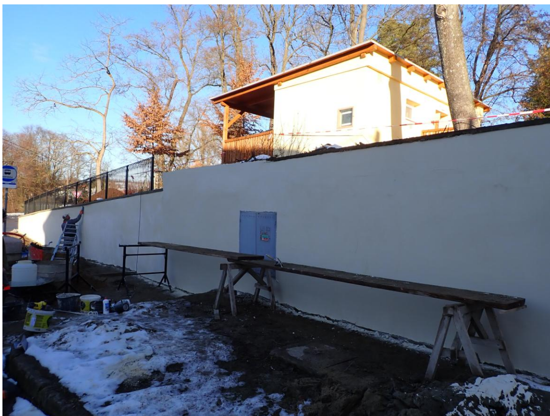
V prostoru za odstraněnou zastávkou dojde v části k doplnění ž.b. zhlaví, k následné reprofilaci stávajícího zhlaví a k doplnění kovového zábradlí.
