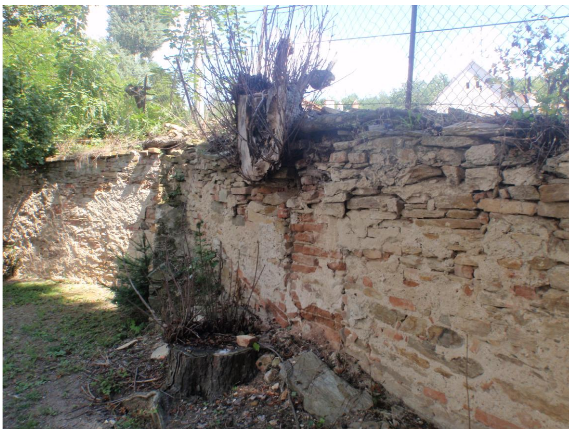
Vegetace z dřívku zdiva V. úseku bude odstraněna, narušené části zdiva budou rozebrány a opětovně vyzděny.
