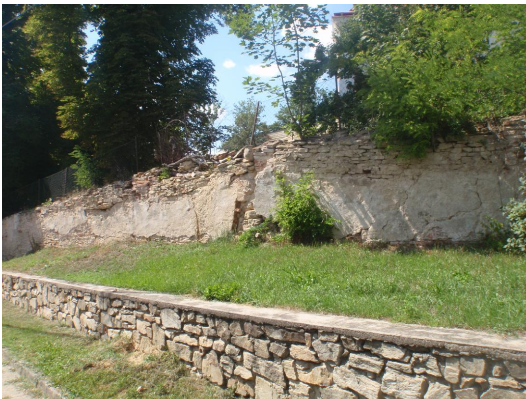
Pohled na V. úsek. Dojde zde k obnovení cihelného zhlaví a realizaci nového oplocení v koruně.
